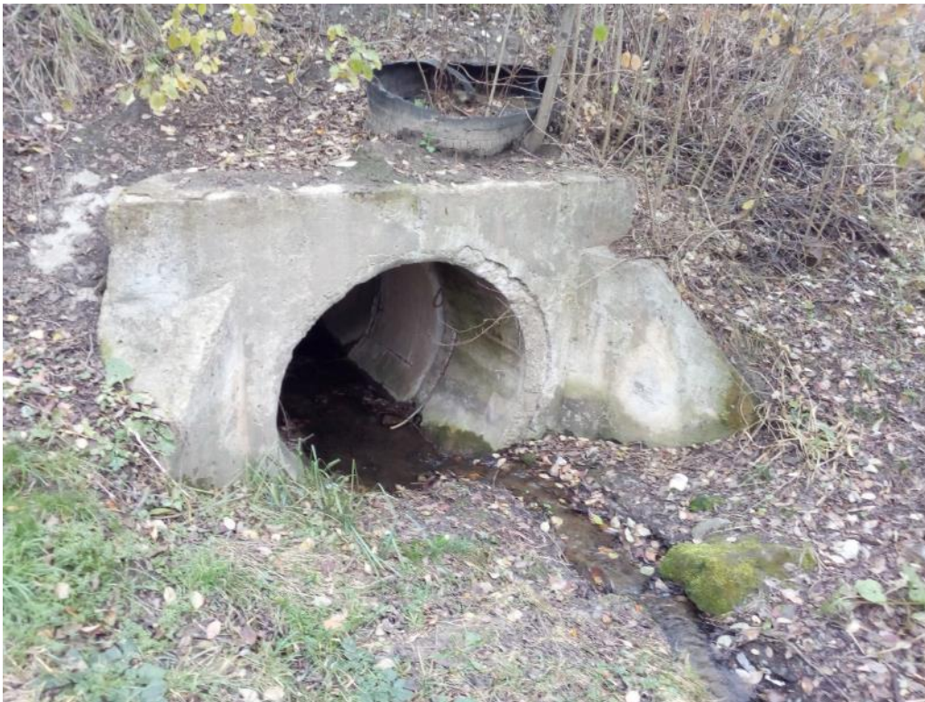
Фото 13. Трубчатий переїзд під вул. Юзвинська
