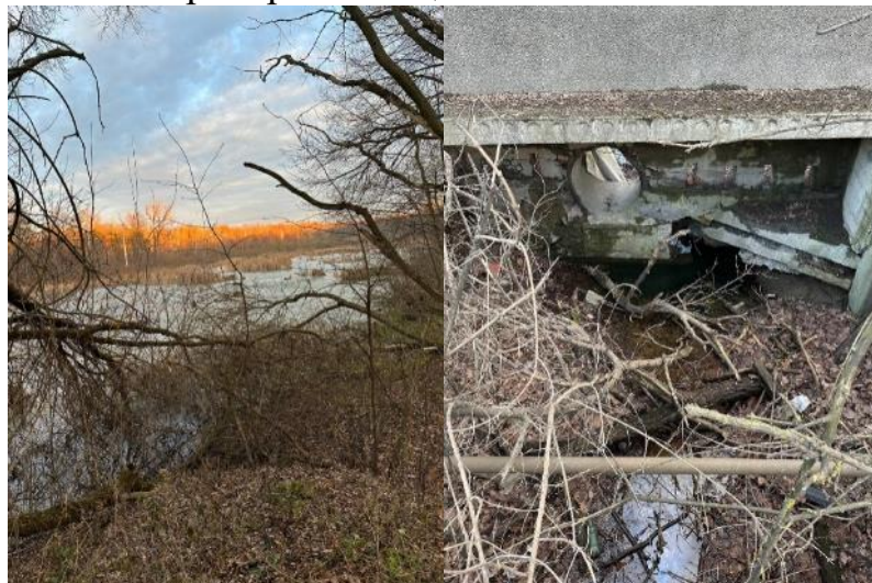
Фото 76, 77. Річка Вельбешівка до містка по вул. Київська
