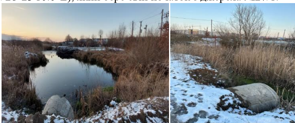
Фото 19, 20. Струмок під насипом дороги
