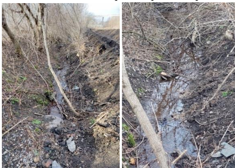
Фото 93, 94. Вихід русла з труби
