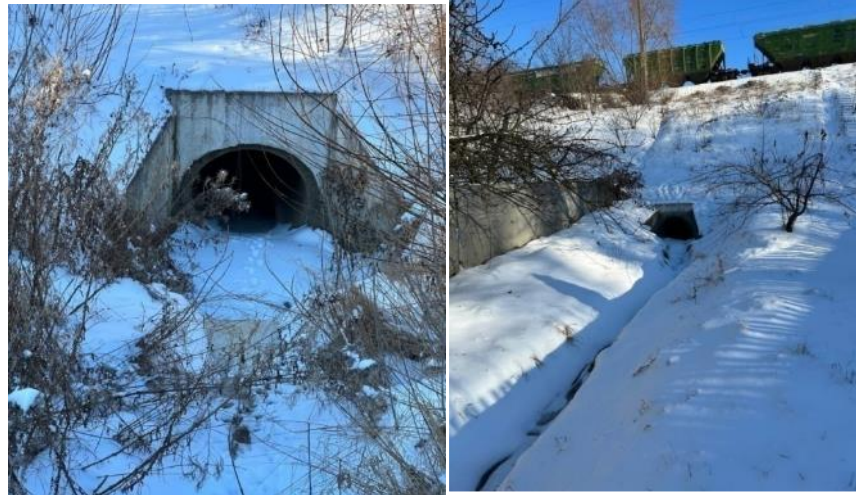
Фото 99, 100. Вихід струмка з-під залізничної дороги
